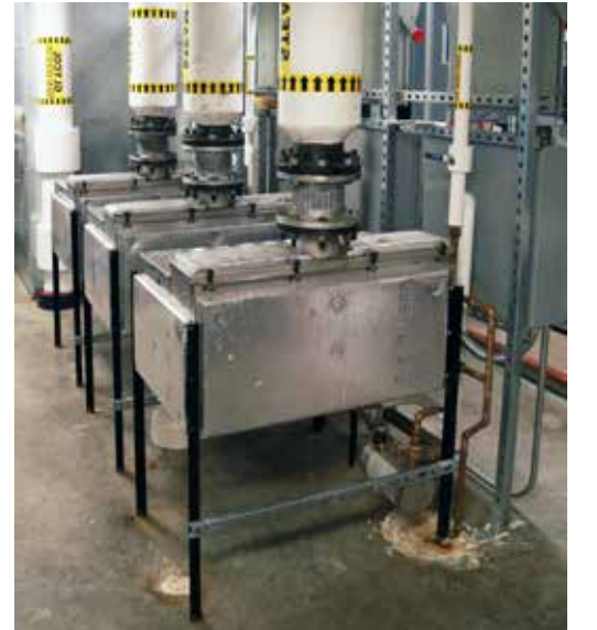
أجهزة ترطيب Vaporstream ثلاثة أجهزة ترطيب Vaporstream توفر الرطوبة في مركز للفنون المسرحية.
