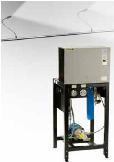
El sistema de alta presión DriSteem ofrece enfriamiento y humidificación por evaporación para varias zonas en climatizadores, conductos y espacios abiertos. El controlador Vapor-logic proporciona una gestión completa de todas las variables del sistema.
