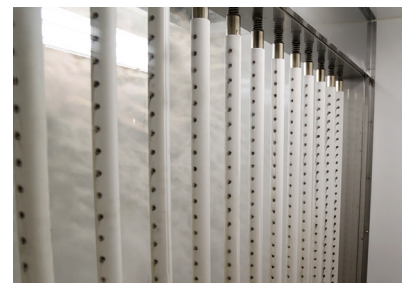
Panel do dyspersji pary Ultra-sorb® XV firmy DriSteem
