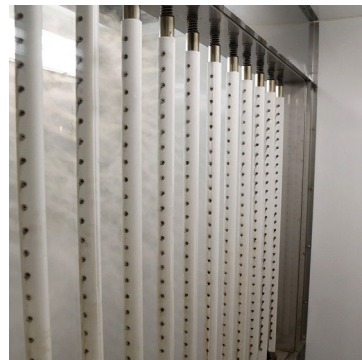
등온식 (증기) 가습기: 가습기 탱크 내에서 물을 끓여 증기를 생성하고 이를 스팀 매니폴드를 통해 덕트내부로 배출하거나 직접 공간 안으로 분배합니다.
