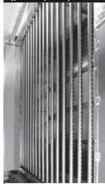
Dargestellt ist ein typisches Dampfverteilsystem mit ungedämmten Edelstahlverleibern montiert über die gesamte Breite und Höhe eines Luftkanals. Diese Verteilrohre injizieren Dampf beständig, senkrecht zum Luftstrom.
